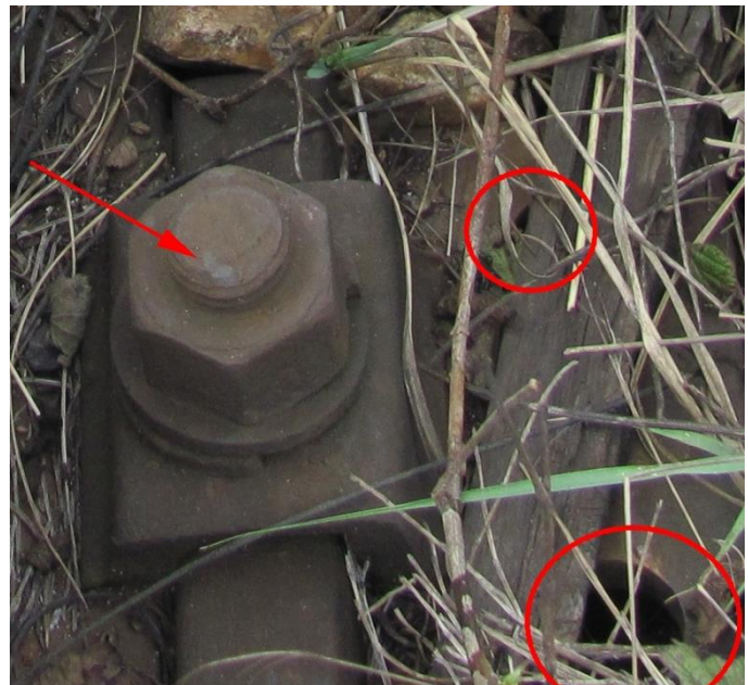
Слика 4.1.3: Стање прага и причврсног прибора код прага 0Л
