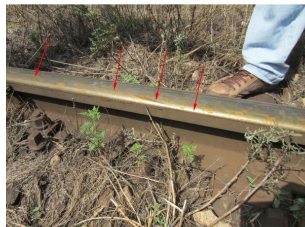
Слика 4.1.7: Трагови првог исклизнућа десног точка на 25 m иза места упадања левог точка у колосек
